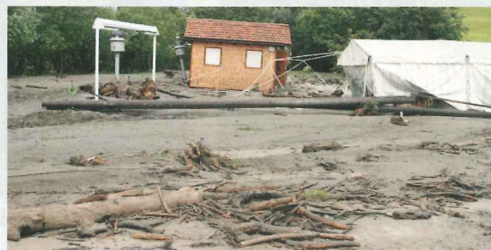
Das Bahnhofsgebäude wurde von der Elektroinstallation zurückgehalten.
