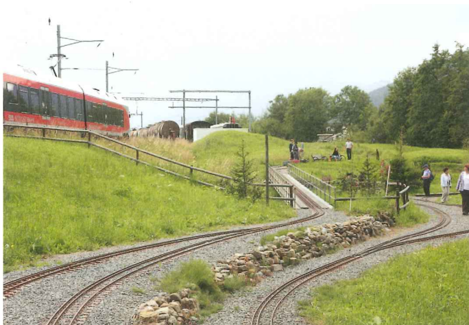
Die Anlage «Blatten» liegt am Fusse der SOB-Linie nach Einsiedeln.
