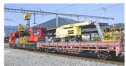
Der Fahrleitungsdienst der SOB entfernt den Fahrdrabt für die folgende Kranoperation.
